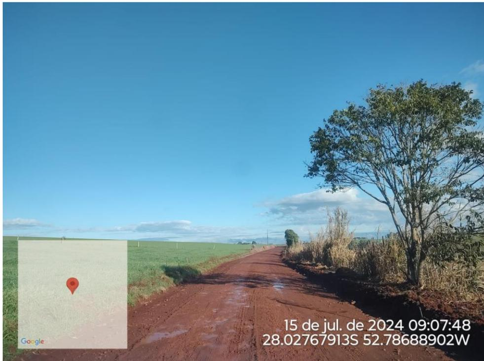
Foto 6– Via existente, apenas conformação da plataforma e execução de Revestimento Primario.
