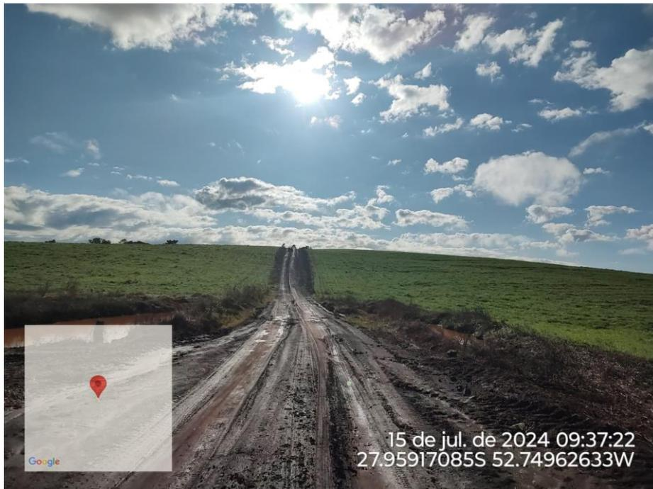
Foto 13 – Via existente, apenas conformação da plataforma e execução de Revestimento Primario.
