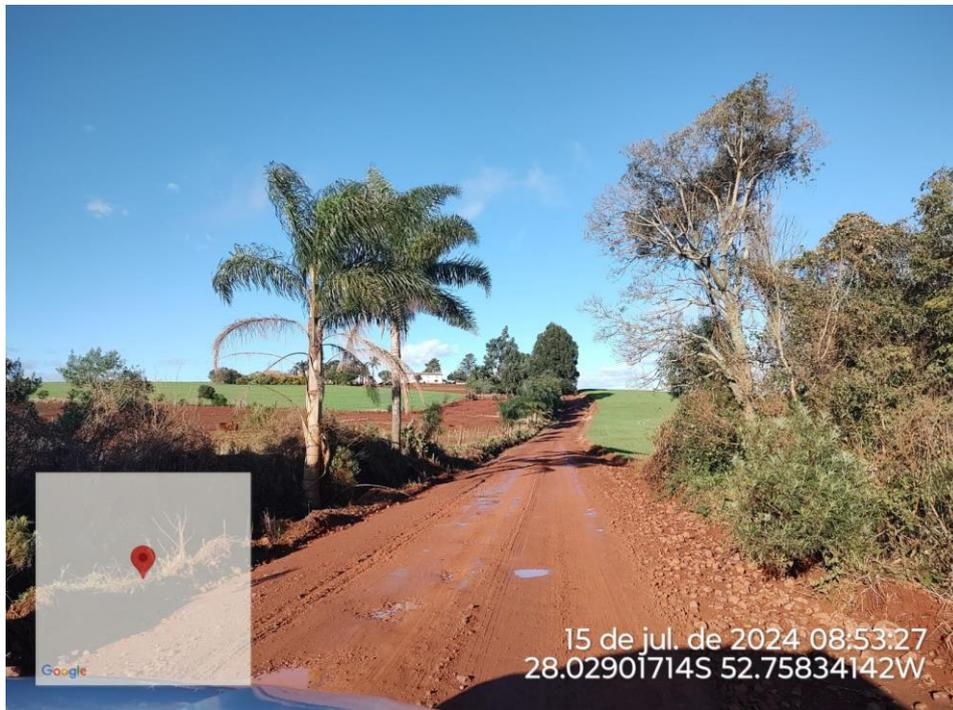
Foto 21– Via existente, apenas conformação da plataforma e execução de Revestimento Primario
