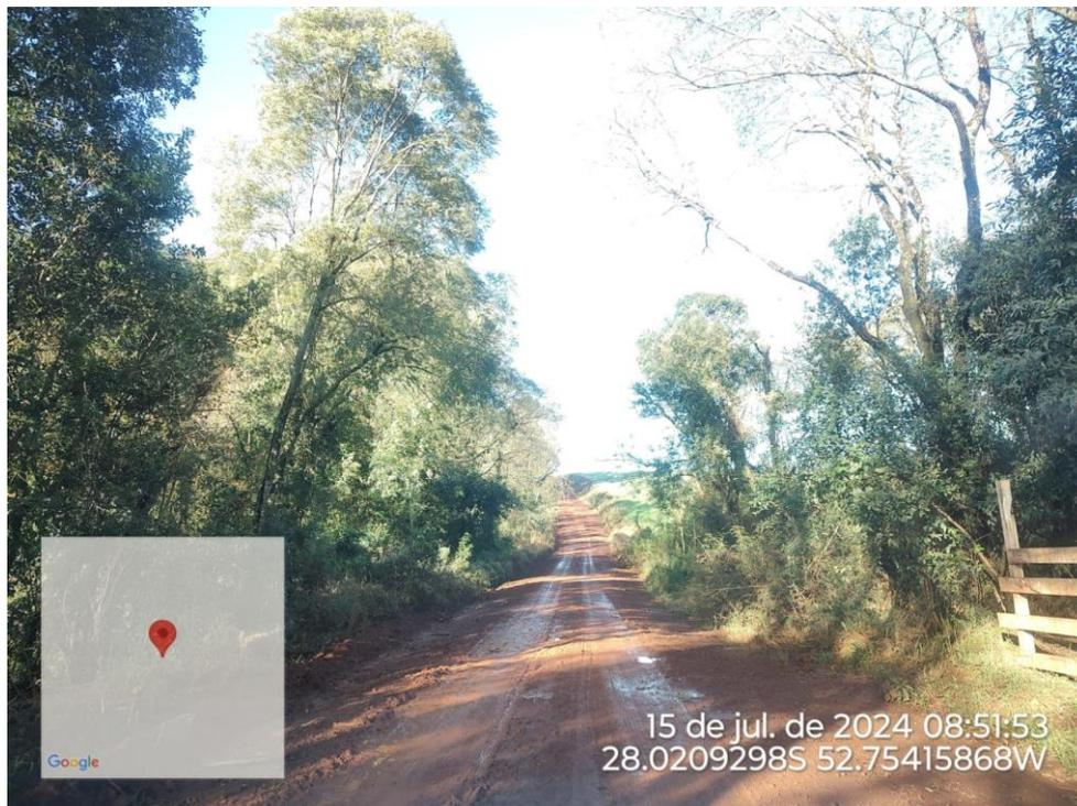
Foto 22– Via existente, apenas conformação da plataforma e execução de Revestimento Primario
