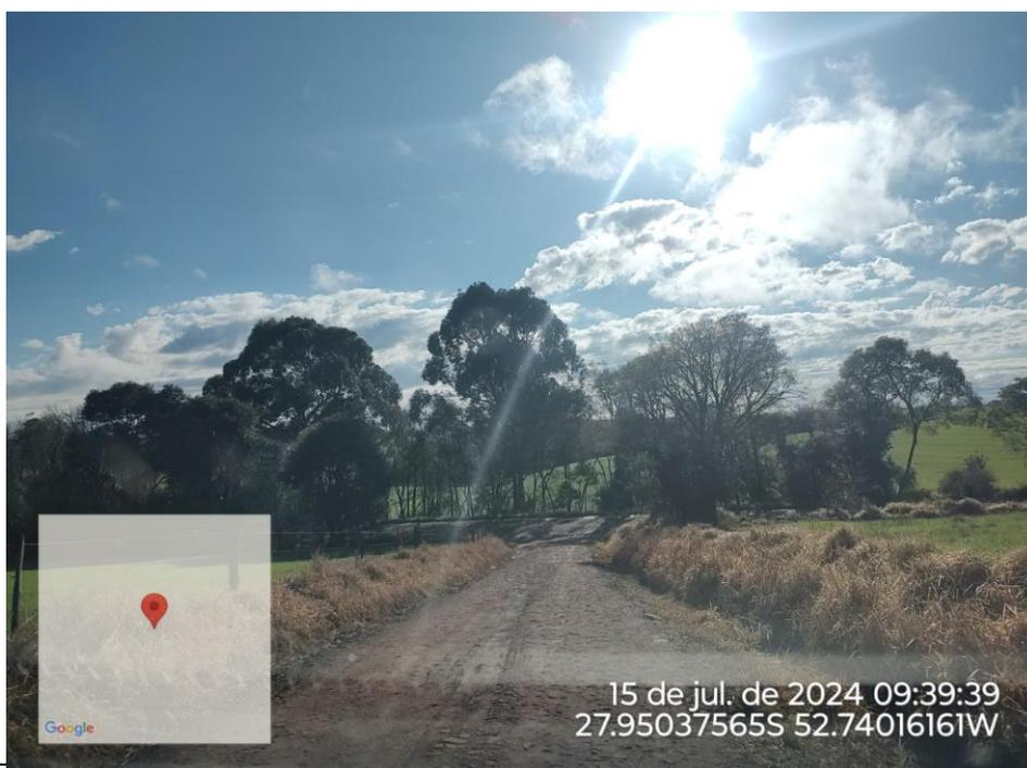
Foto 12 – Via existente, apenas conformação da plataforma e execução de Revestimento Primario.
