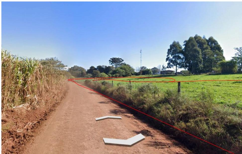
Foto 01– Via existente, apenas conformação da plataforma e execução de Revestimento Primario
