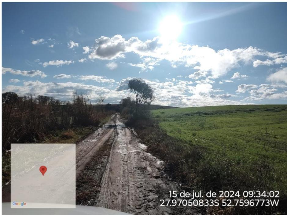
Foto 14 – Via existente, apenas conformação da plataforma e execução de Revestimento Primario.
