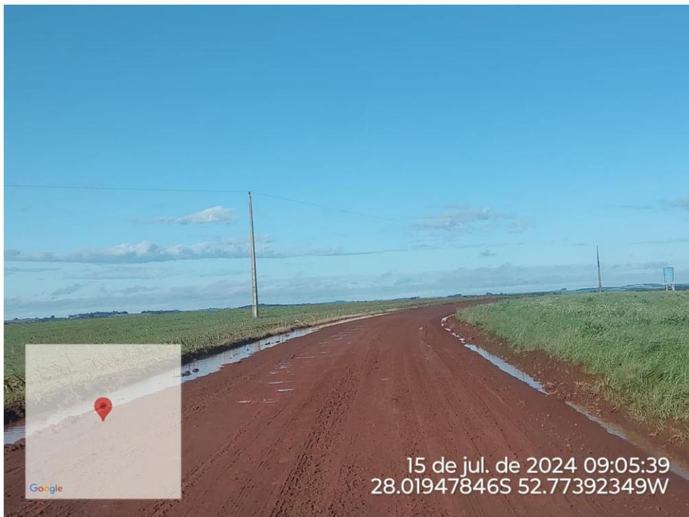
Foto 7– Via existente, apenas conformação da plataforma e execução de Revestimento Primario.
