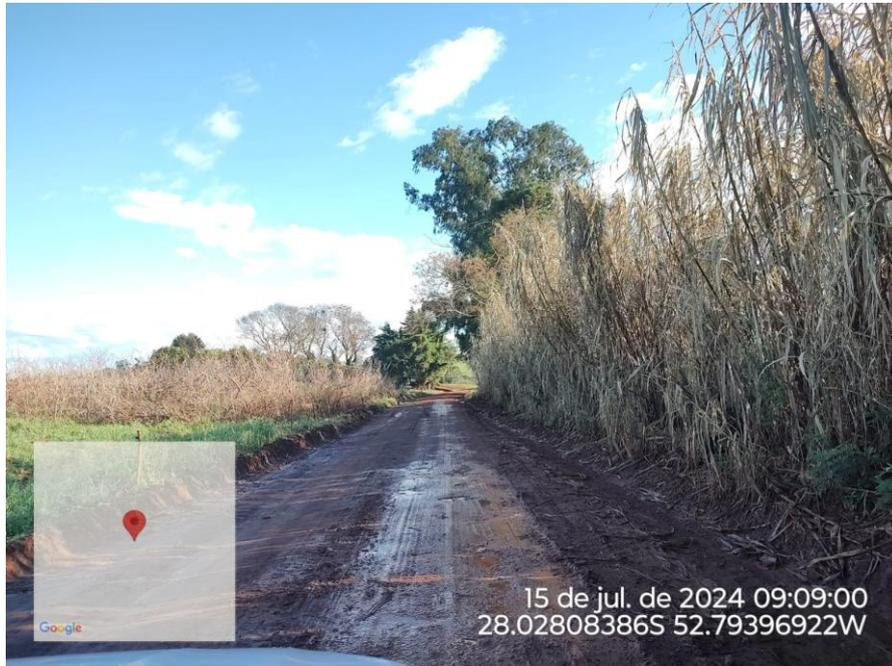
Foto 5– Via existente, apenas conformação da plataforma e execução de Revestimento Primario.
