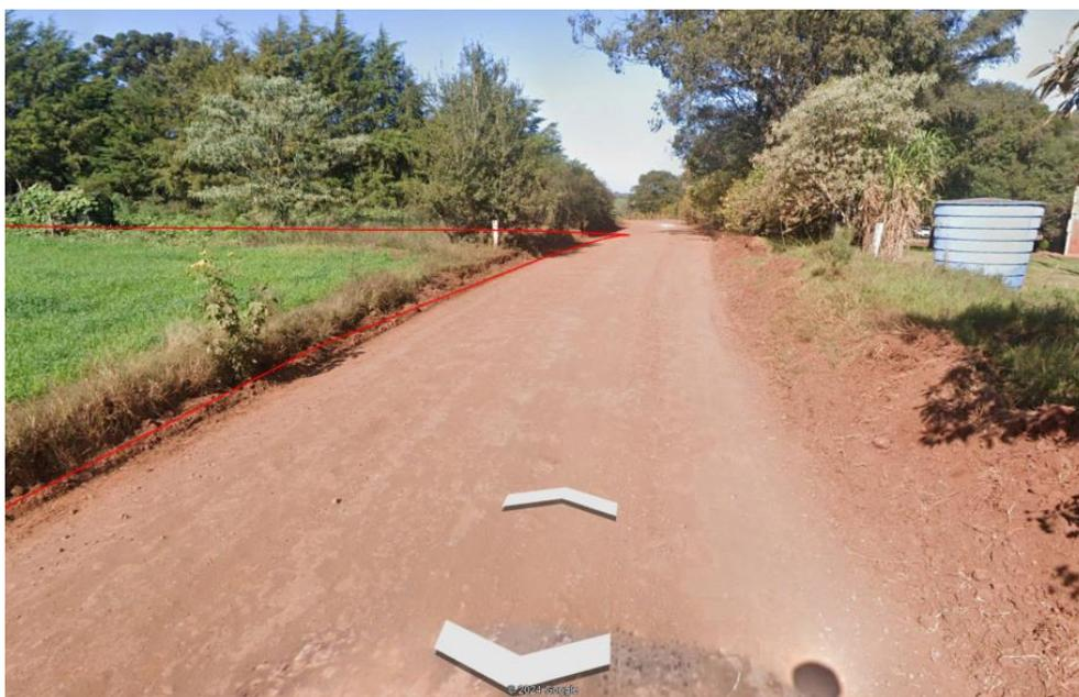
Foto 03– Via existente, apenas conformação da plataforma e execução de Revestimento Primario
