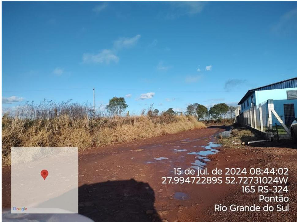
Foto 25– Via existente, apenas conformação da plataforma e execução de Revestimento Primario
