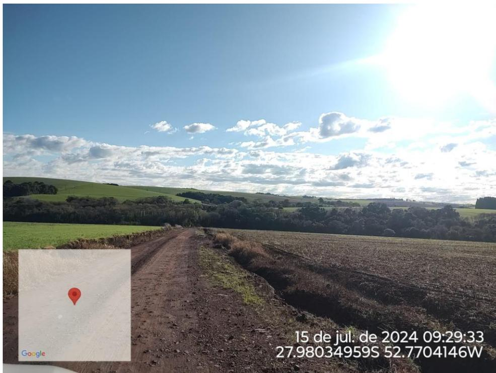
Foto 16– Via existente, apenas conformação da plataforma e execução de Revestimento Primario.
