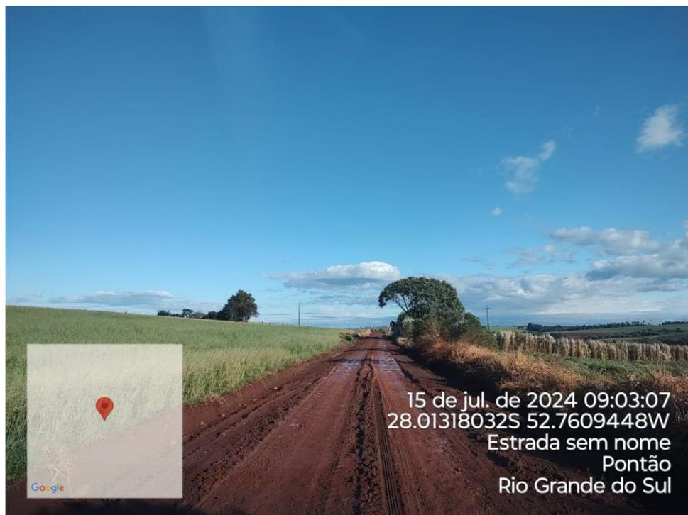
Foto 10– Via existente, apenas conformação da plataforma e execução de Revestimento Primario
