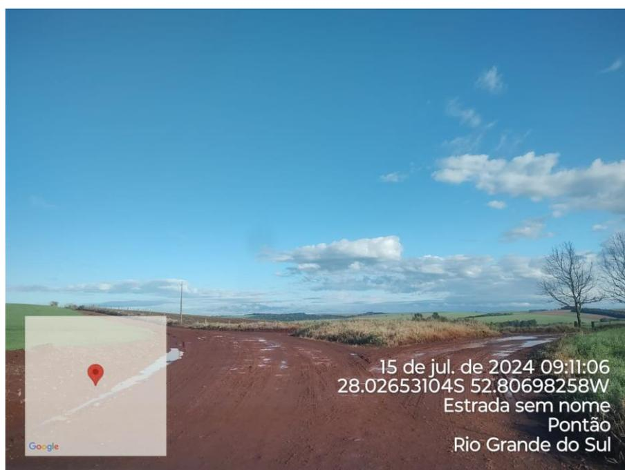
Foto 4– Via existente, apenas conformação da plataforma e execução de Revestimento Primario.
